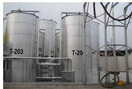
Das Altspeiseöl wird gereinigt und aufbereitet. Es wird danach an Biodiesel-Raffinerien in NÖ geliefert. Hier erfolgt die Veresterung unter Zugabe von Methanol. Reste aus der Reinigung (z.B. Brösel,...) werden zu Biogas vergärt.
